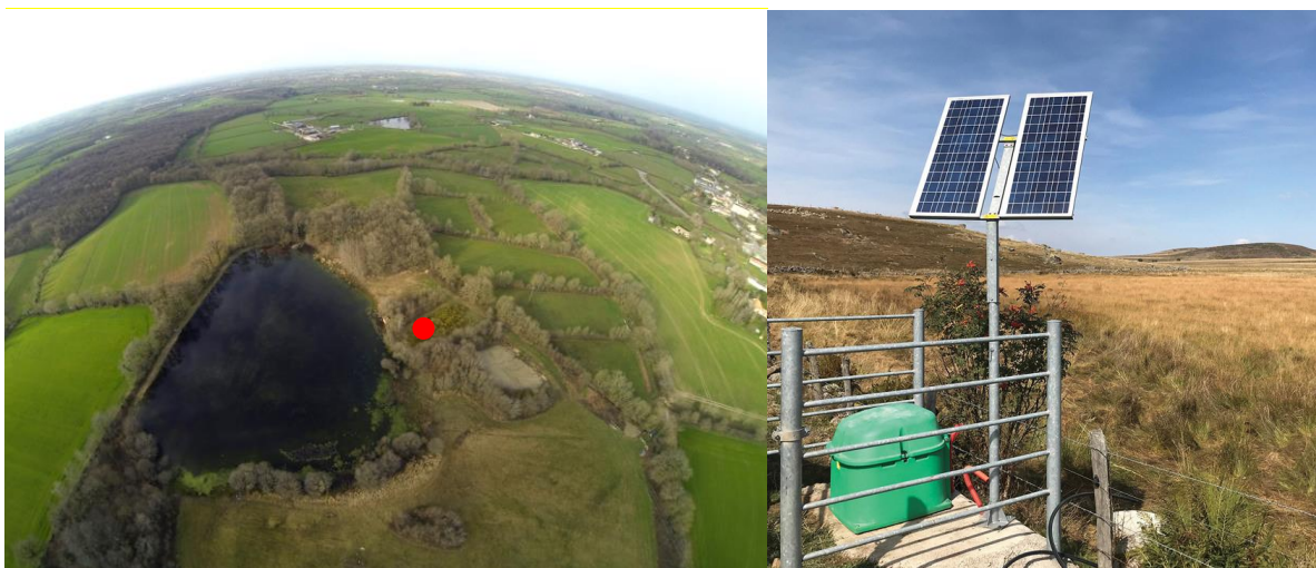
Figure 109 : Localisation de l'installation de la pompe solaire et illustration du projet de système de pompage solaire pour alimenter en eau les bovins qui pâturent sur la RNR. © Jean-Marie Rouvreau et La Buvette
