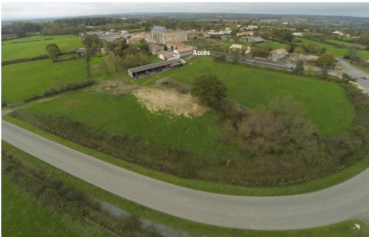
Figure 119 : Vue aérienne des parcelles concernées par le projet de maison de la réserve et d'accueil du public. © Jean-Marie Rouvreau
