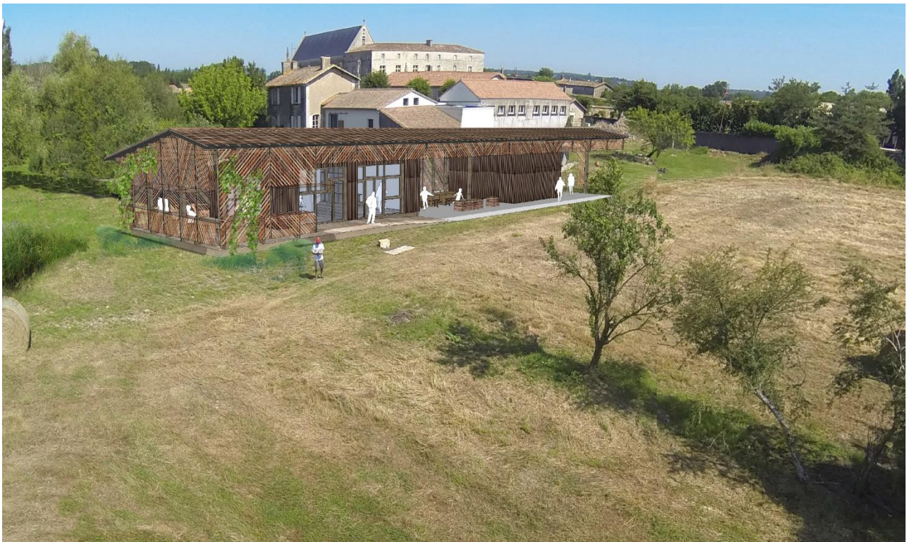
Figure 122 : Vue du bâtiment agricole après éco-rénovation dans son environnement proche. © Jean-Marie Rouvreau et 100 Détours
