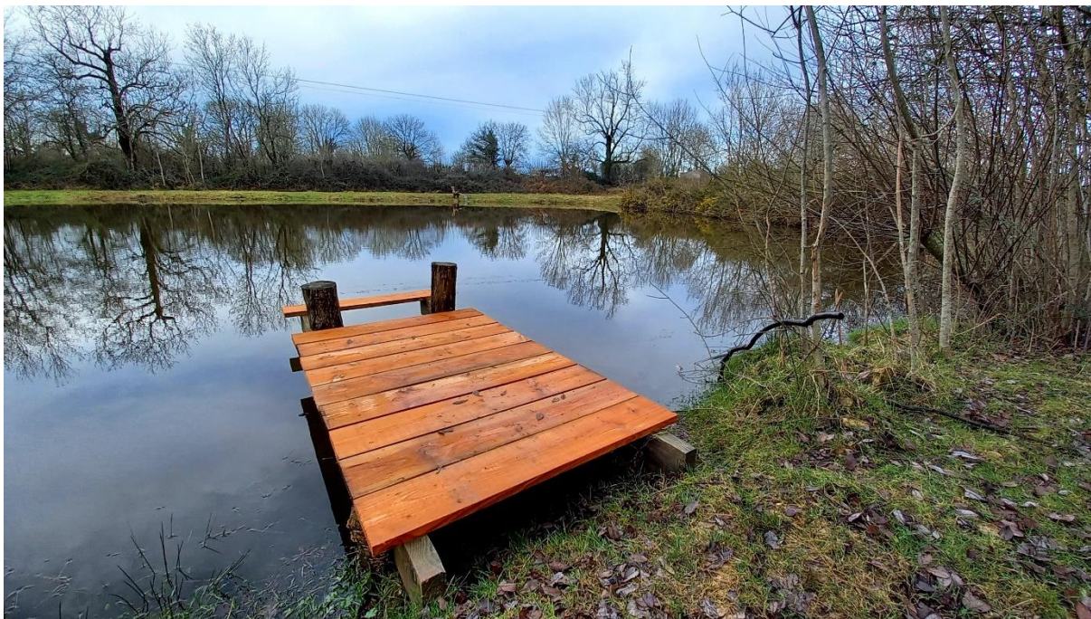
Figure 108 : Finalisation du ponton d'accès au dispositif de gestion du niveau de l'eau sur la réserve de l'étang. © Alexandre Boissinot
