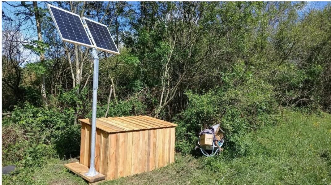
Figure 102 : Système d'abreuvement solaire installé sur la RNR du Bocage des Antonins © Alexandre Boissinot
