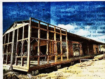
La conclusion du chantier de construction de la Maison de la RNR du bocage des Antonins est espérée pour le mois de juin 2025. Avant l'inauguration en septembre. (Photo NR, Maxime Chataigner)
