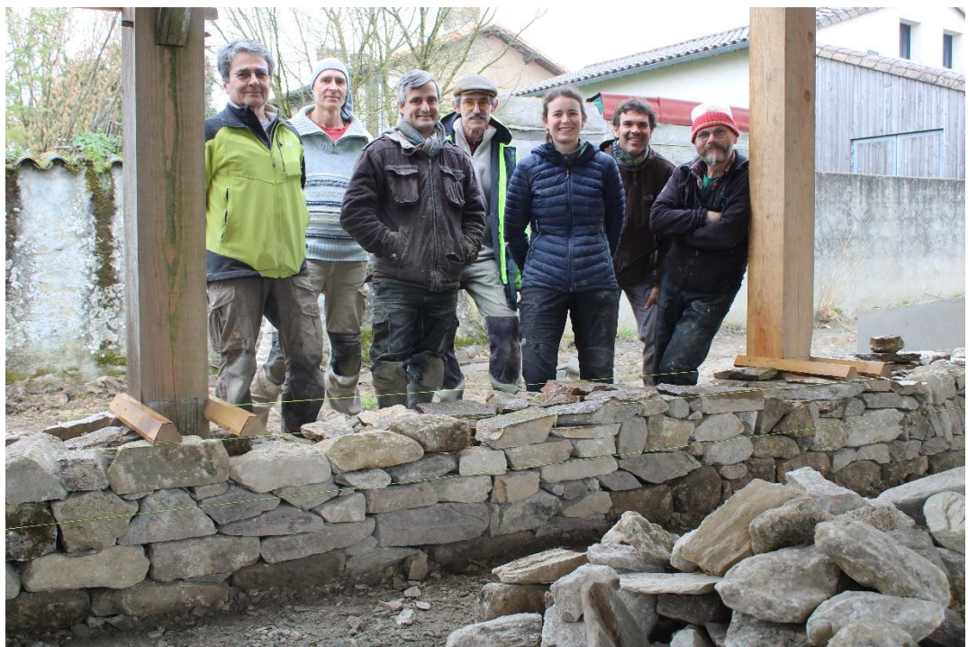
Figure 42 : Réalisation de murets en pierres sèches pour la Maison de la réserve avec des bénévoles de DSNE et encadré par Vincent Boutteaud © Alexandre Boissinot
