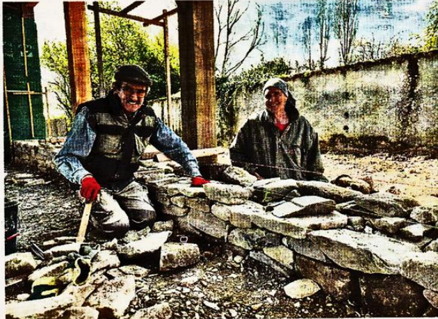
Vincent Boutteaud (à droite), murailleur, a distillé ses conseils aux bénévoles de Deux-Sèvres nature environnement engagés dans ce chantier participatif, à l'instar de Dominique. (Photo NR, Maxime Chataigner)
