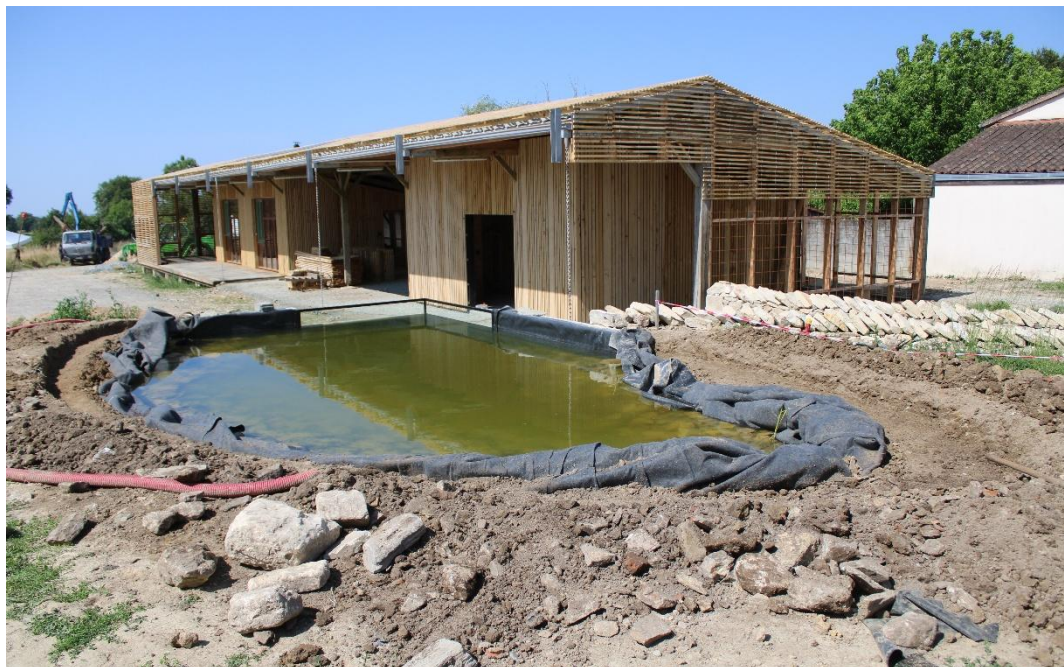
Figure 43 : Réalisation de la mare pédagogique vitrée de la Maison de la réserve © Alexandre Boissinot
