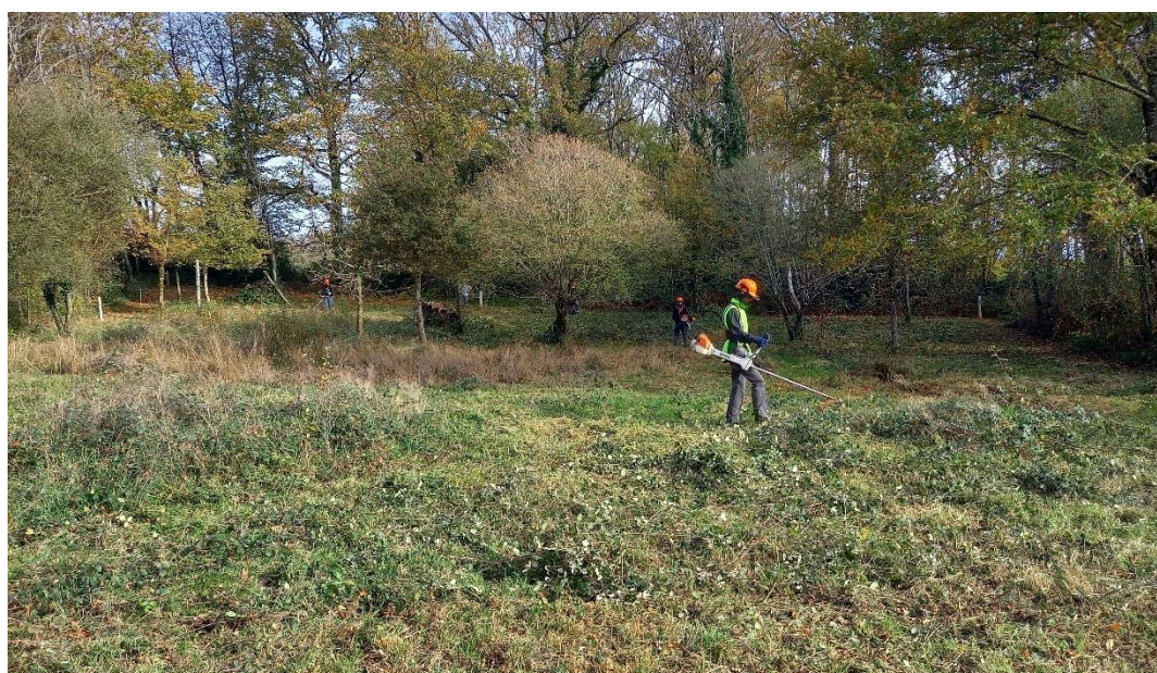
Figure 39 : Chantier du 13 novembre 2025 avec les Bac Pro. GMNF de la MFR de Saint-Loup. © Alexandre Boissinot
